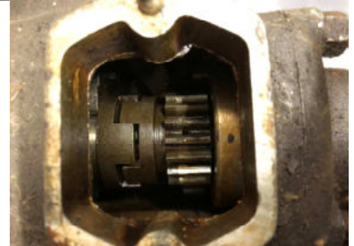
Hiernaast een kijkje in de gespoelde bak. Er kwam een tand van een tandwiel uit, zichtbaar nadat het bruine vet was weg gespoeld. Op deze foto is het defect niet zichtbaar...
